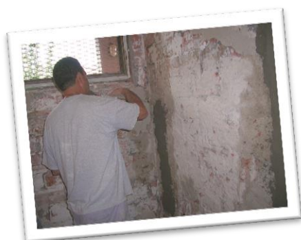
Rehabilitació d'un habitatge
