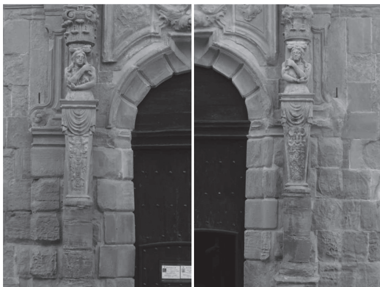
Imatges estípits després de la intervenció
