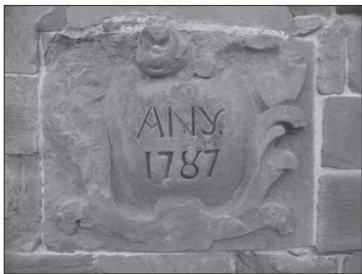
Imatges abans i després de la intervenció
