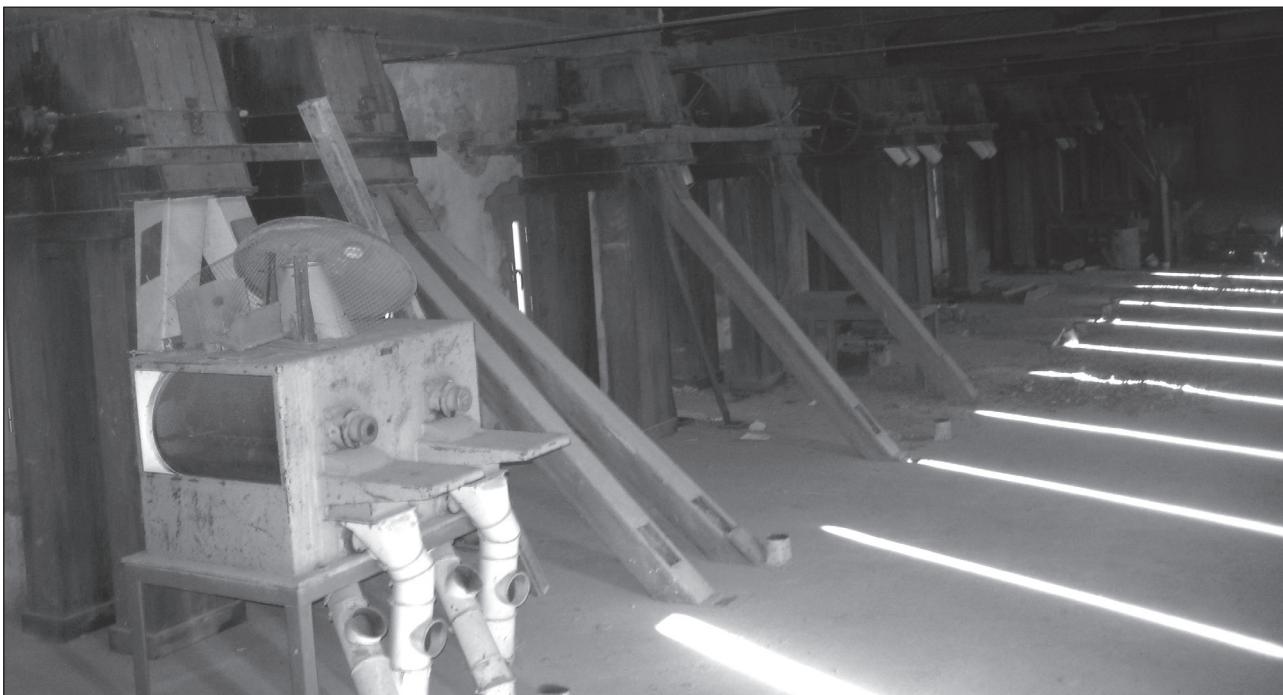
Darrera planta de la fàbrica, sota coberta, on veiem el tram final dels elevadors de cullereta encarregats de distribuir primer blat i farina quan acabava el procés de mòlta del blat.
