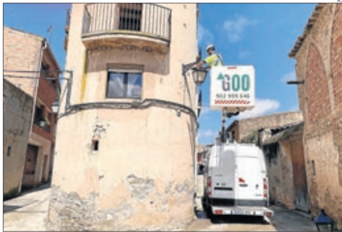
Treballs per renovar l'enllumenat públic de Tarroja.
