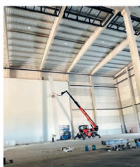
Muntatge cambra temperatura negativa
