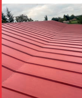
Sostre de panell sandvitx
