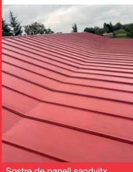
Sostre de panell sandvitx
