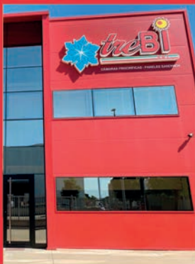
Finestres en policarbonat
