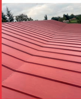
Sostre de panell sandvitx
