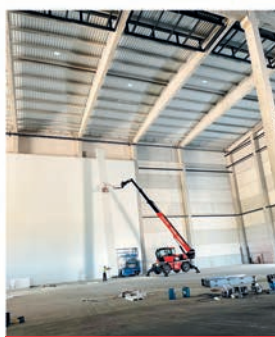
Muntatge cambra temperatura negativa
