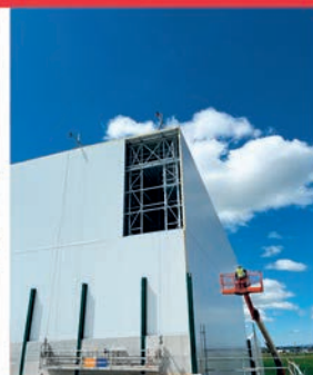
Tancament de silo mecanitzat
