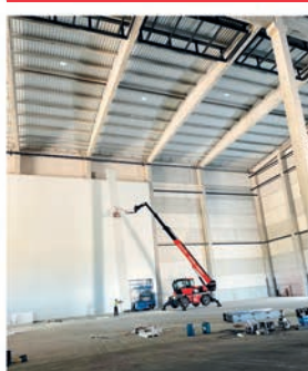
Muntatge cambra temperatura negativa
