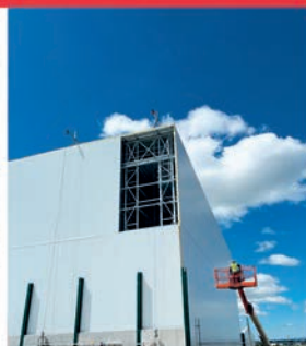
Tancament de silo mecanitzat
