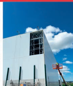
Tancament de silo mecanitzat
