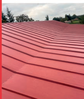
Sostre de panell sandvitx
