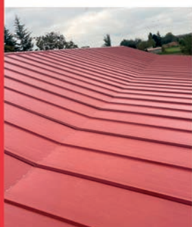
Sostre de panell sandvitx
