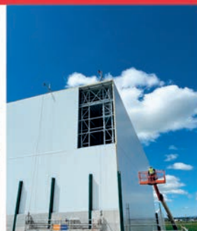
Tancament de silo mecanitzat
