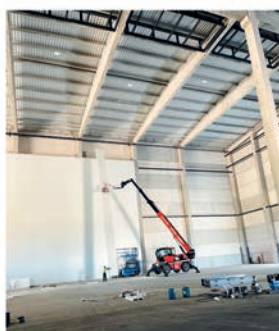
Muntatge cambra temperatura negativa
