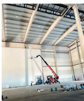
Muntatge cambra temperatura negativa
