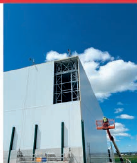
Tancament de silo mecanitzat
