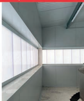
Finestres en policarbonat
