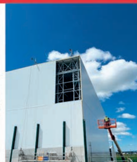
Tancament de silo mecanitzat
