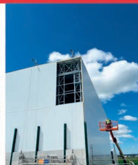
Tancament de silo mecanitzat
