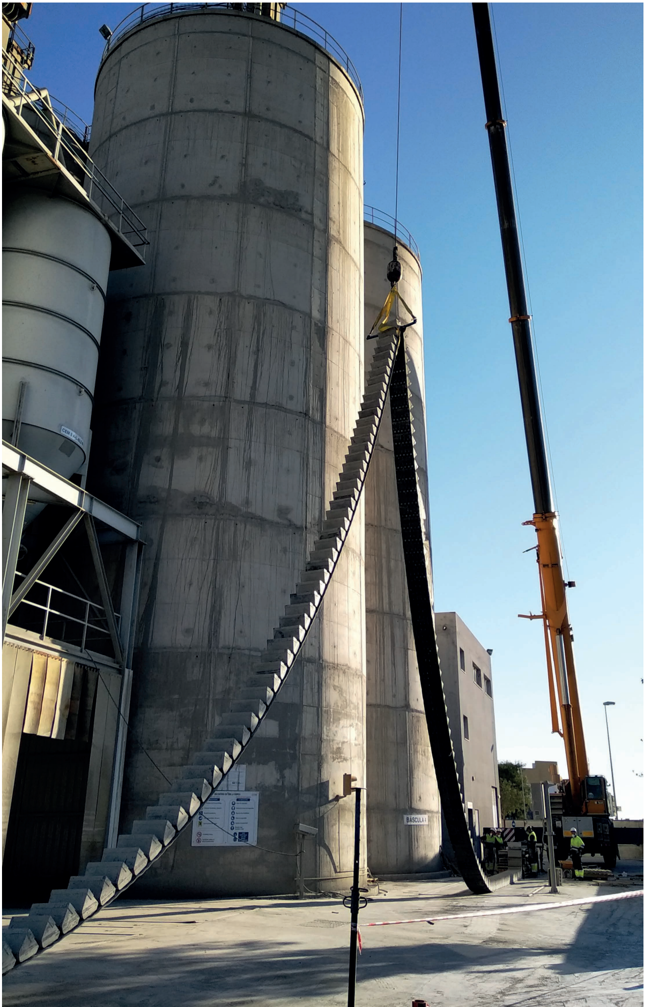
Aplicación I Montaje de una banda elevadora.
