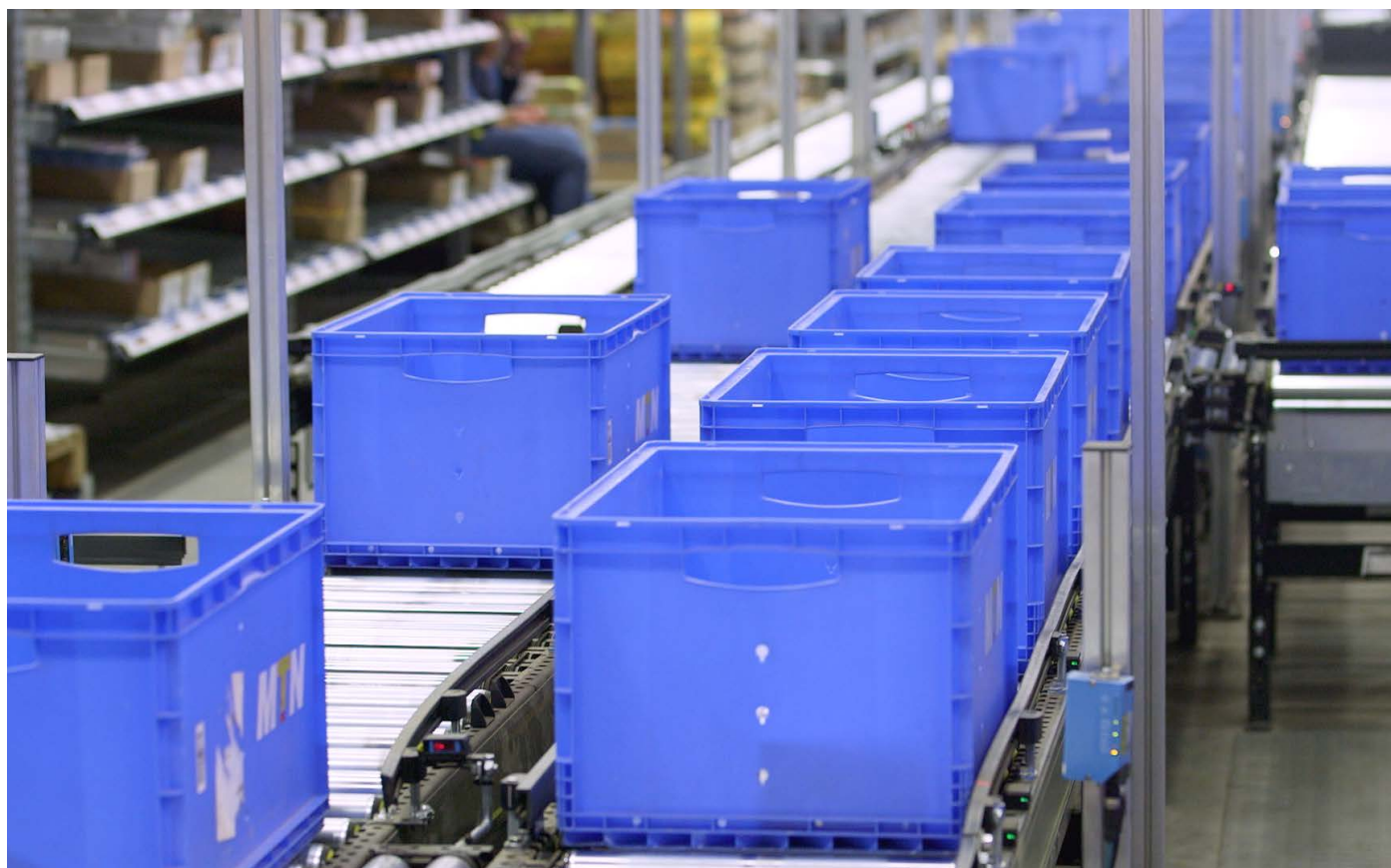
Rodillos motorizados como parte del sistema de transporte automatizado.
